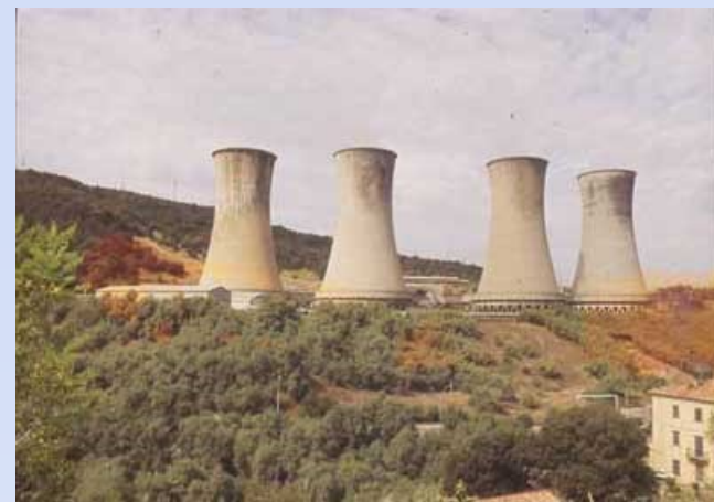
Torri di raffreddamento (Larderello) sezione iperbolica
